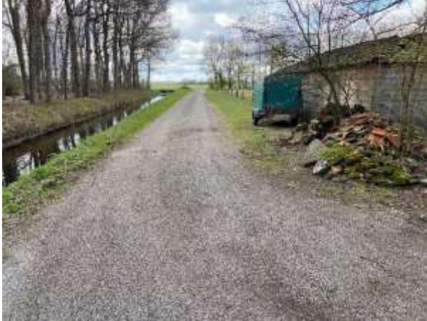
Figuur 9: Overzichtsfoto puinverharding
