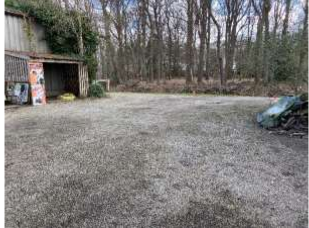
Figuur 10: Overzichtsfoto puinverharding
