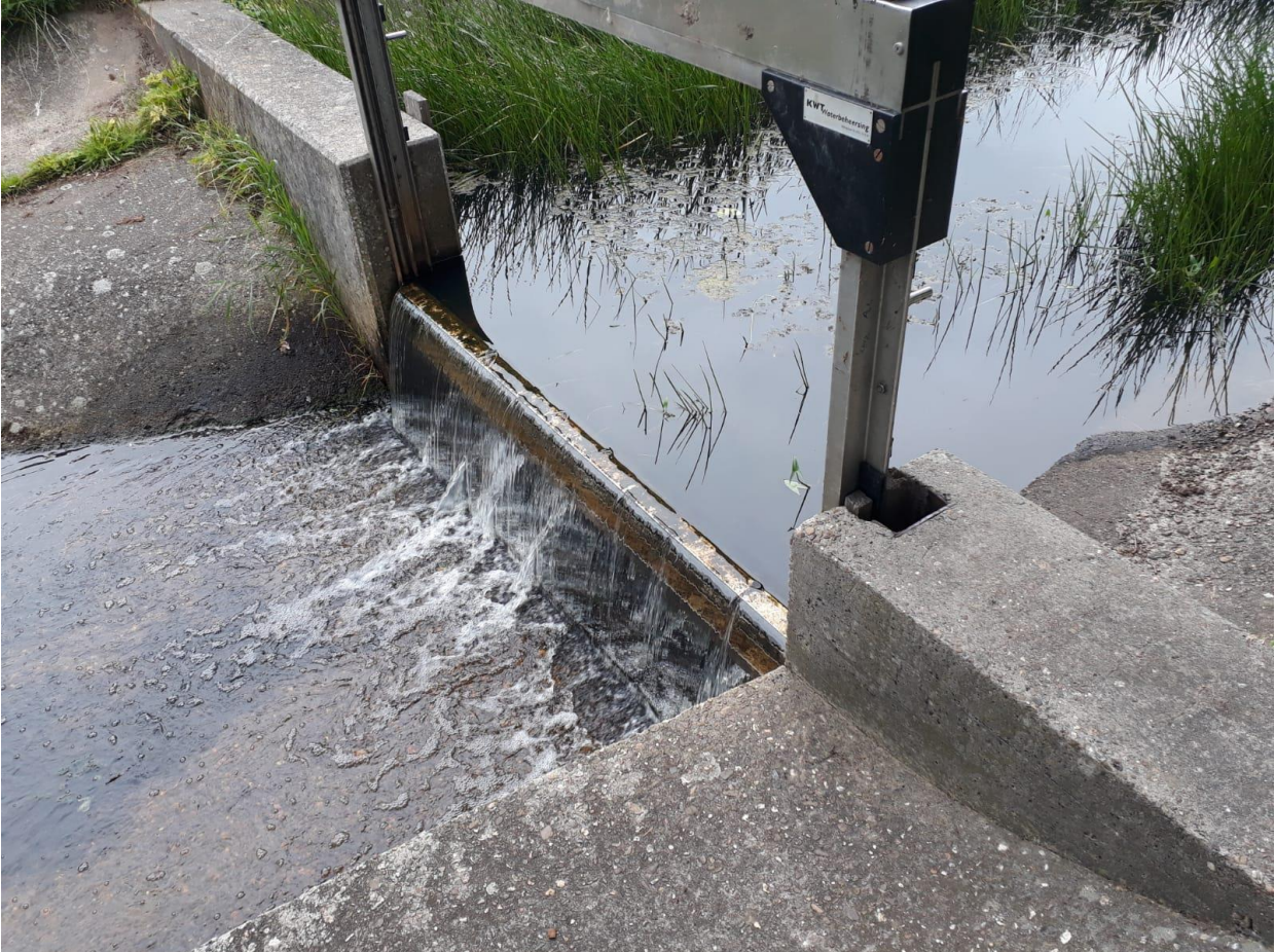
Stuw Plaggemars, detail schuif en regelwerk (locatie A1, ST03347)
