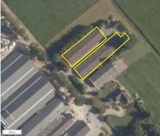
Luchtfoto van het plangebied. De te slopen gebouwen worden met de gele lijn aangeduid (bron luchtfoto: ruimtelijkeplannen.nl).
