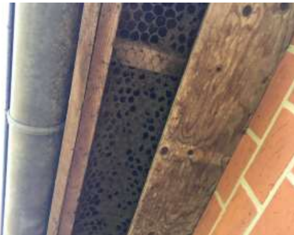
De betimmering van de overstek sluit naadloos aan op de buitengevel
