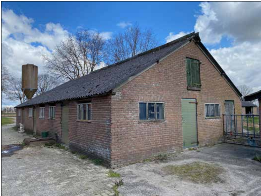
bestaande schuur is nu landschapsontsierend
