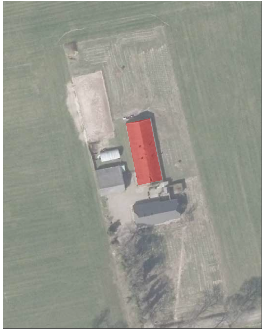
te slopen 435 m 2 aan de Kolonie 1 te Balkbrug
