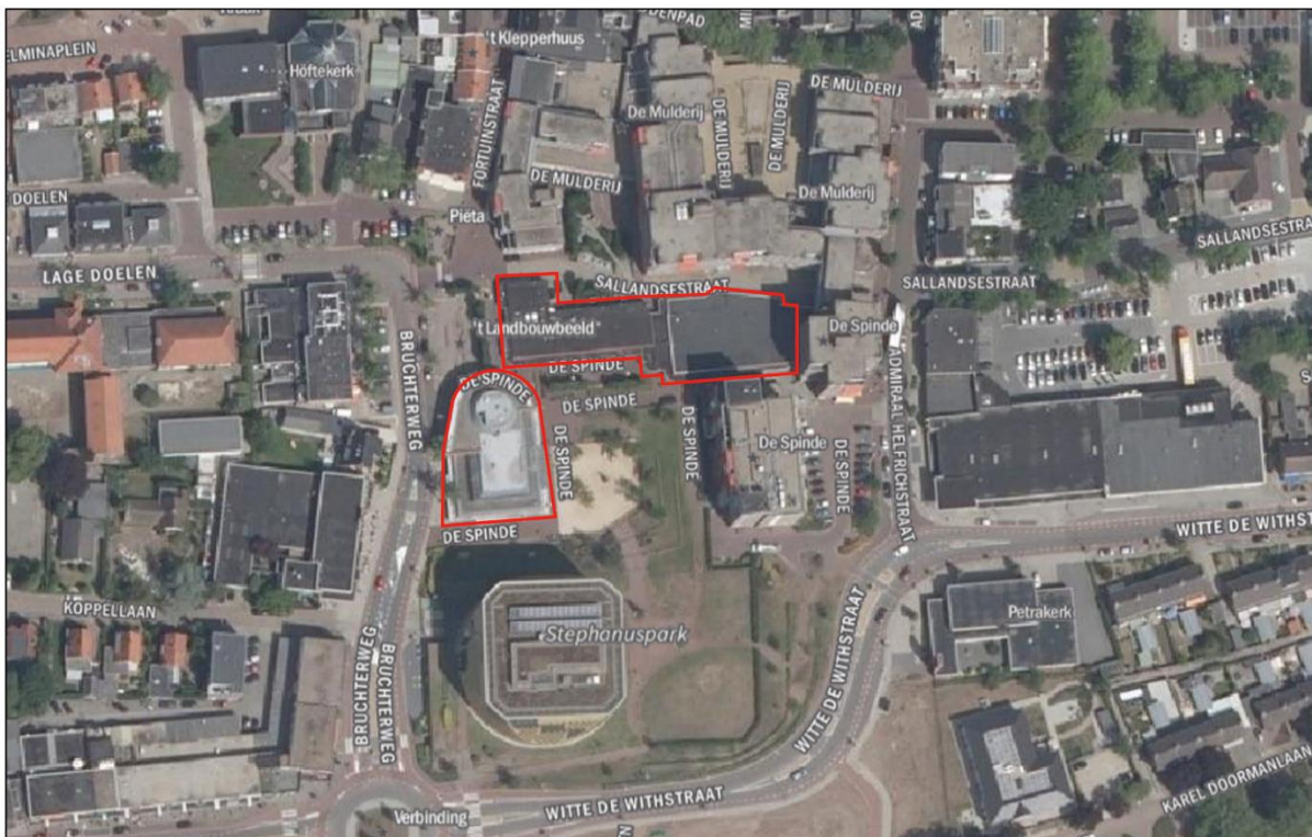
Afbeelding 2.1 Te slopen bebouwing de Spinde (Bron: PDOK)
