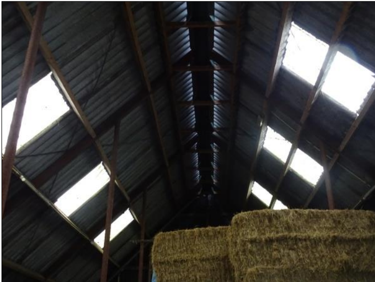
Figuur 3. Binnenzijde van schuur 1, met de goot onder de open nok.
