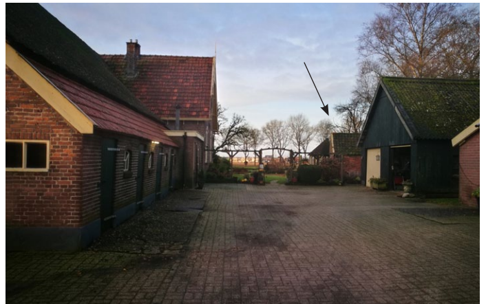
Zicht over het erf richting het westen met de bestaande woning links en het bakhuisje rechts bij de pijl
