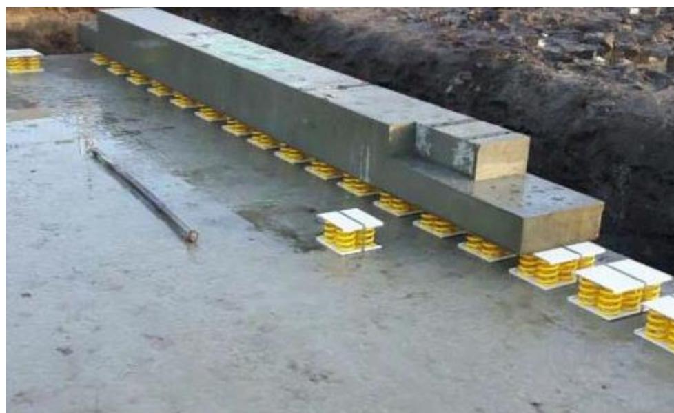
Figuur 14 Dubbele fundering met stalen veerdozen (project in Prinsenbeek)
