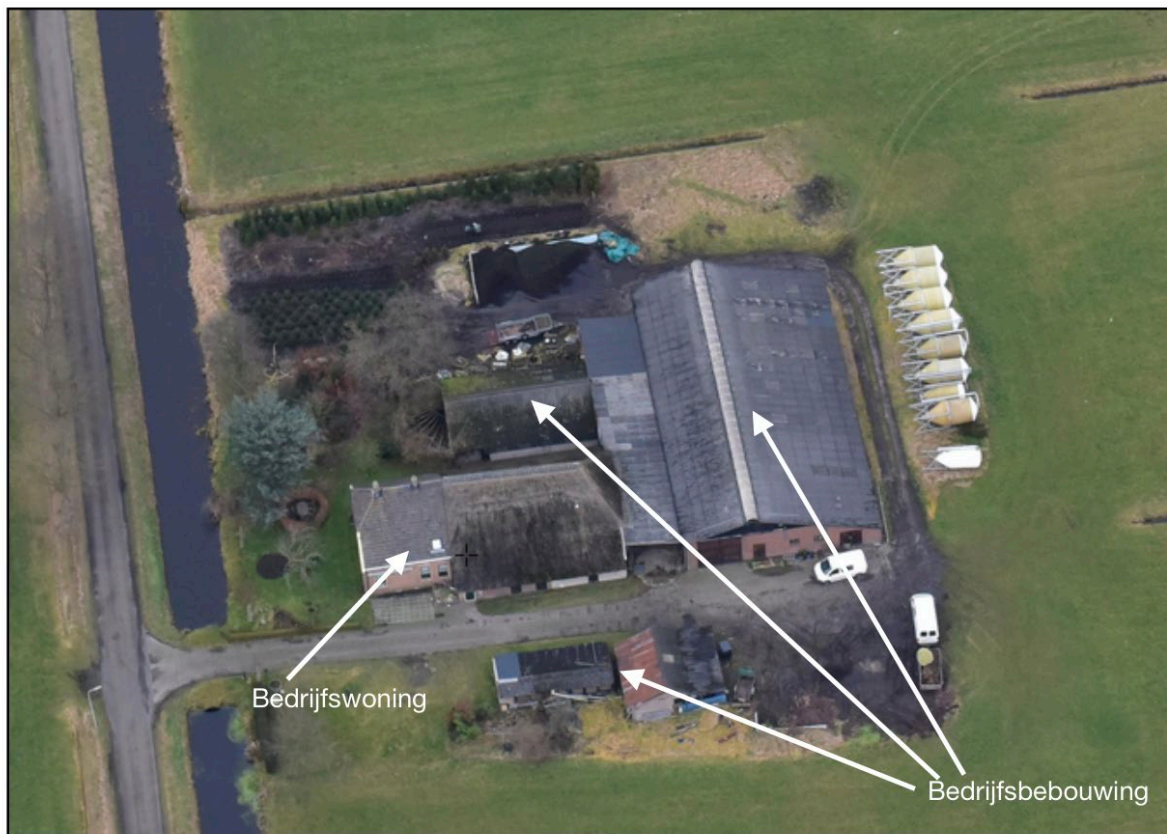
Afbeelding 5.3: Luchtfoto erfsituatie 1 e Schansweg 15 (Bron: Gemeente Hardenberg)
