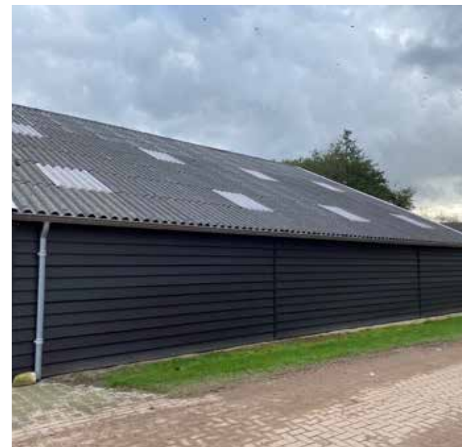
de bestaande reeds opgeknapte te behouden schuur
