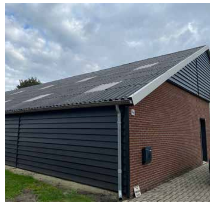
de bestaande reeds opgeknapte te behouden schuur
