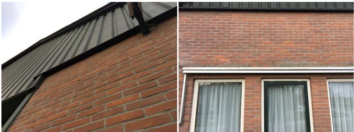
Detailopnames van de buitengevel. Geen open stootvoegen en geen andere openingen die vleermuizen de kans geven een verblijfplaats in de spouw te bezetten.
