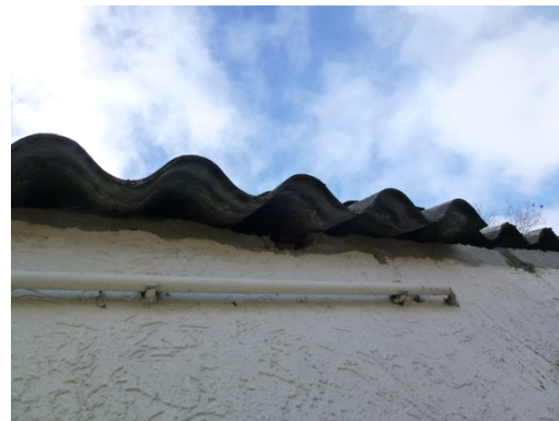
Voorbeeld van ruimte tussen de golfplaten van het dak en de gevelmuur van de schuur.
