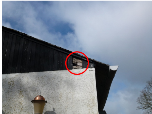
Foto van een beschadiging in de gevelbetimmering van de schuur.
