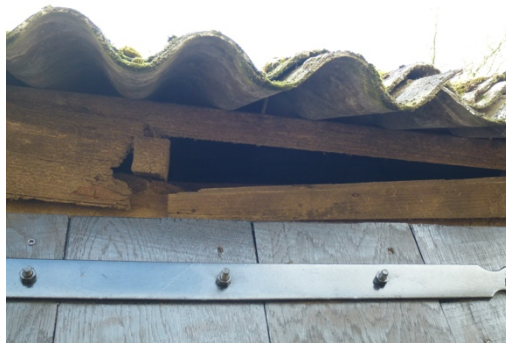
Voorbeeld van beschadigingen van het hout onder de golfplaten van het dak van de schuur.
