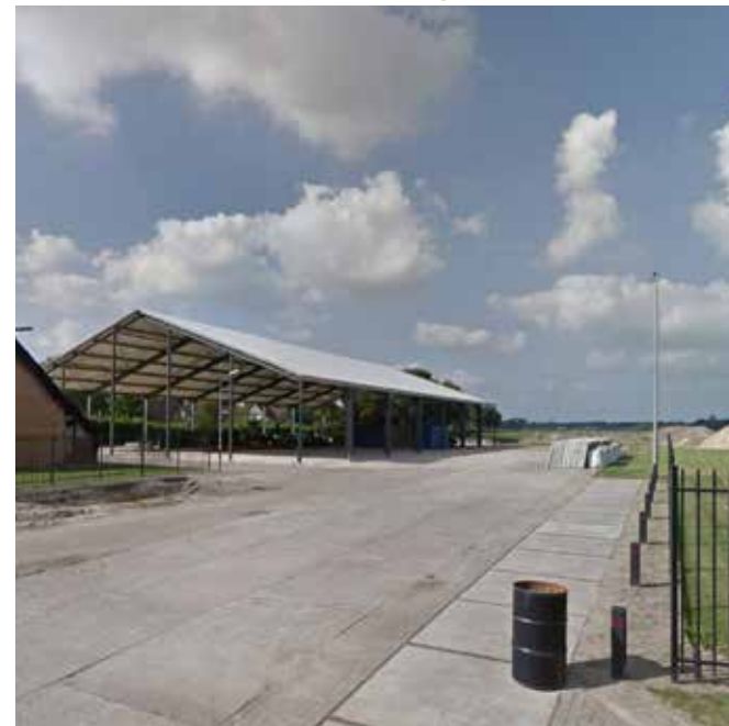
overige erf wordt gesaneerd
