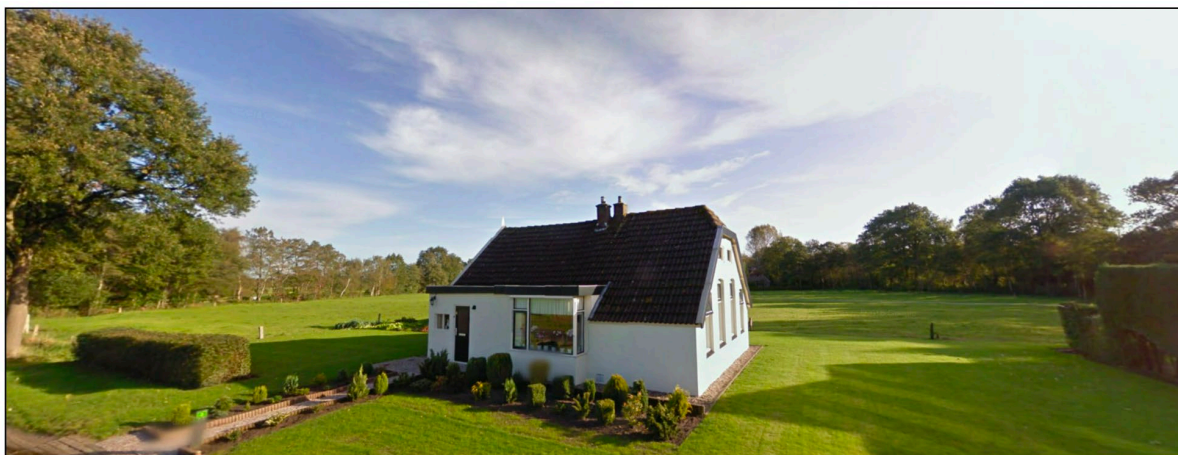
Figuur 2.2 Straatbeeld (Bron: Google Streetview)
