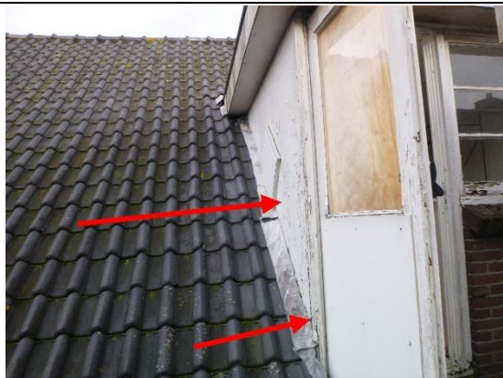
Foto 34 | Foto voor bron vlakke plaat(zijwangen)
