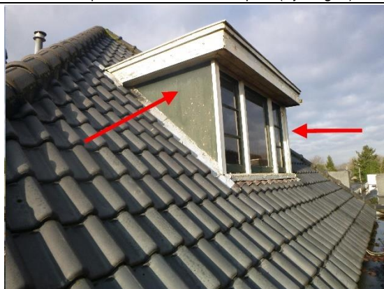
Foto 36 | Foto voor bron vlakke plaat(zijwangen)
