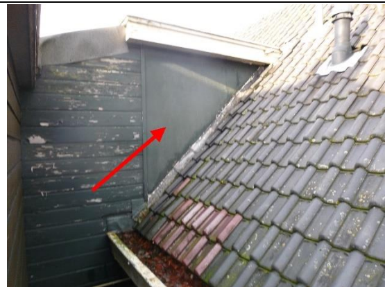
Foto 35 | Foto voor bron vlakke plaat(zijwangen)
