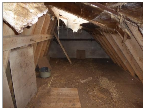
Links: oude ontlasting van een steenmarter. Rechts: kleine zolder waar isolatiemateriaal is weg geknaagd.
