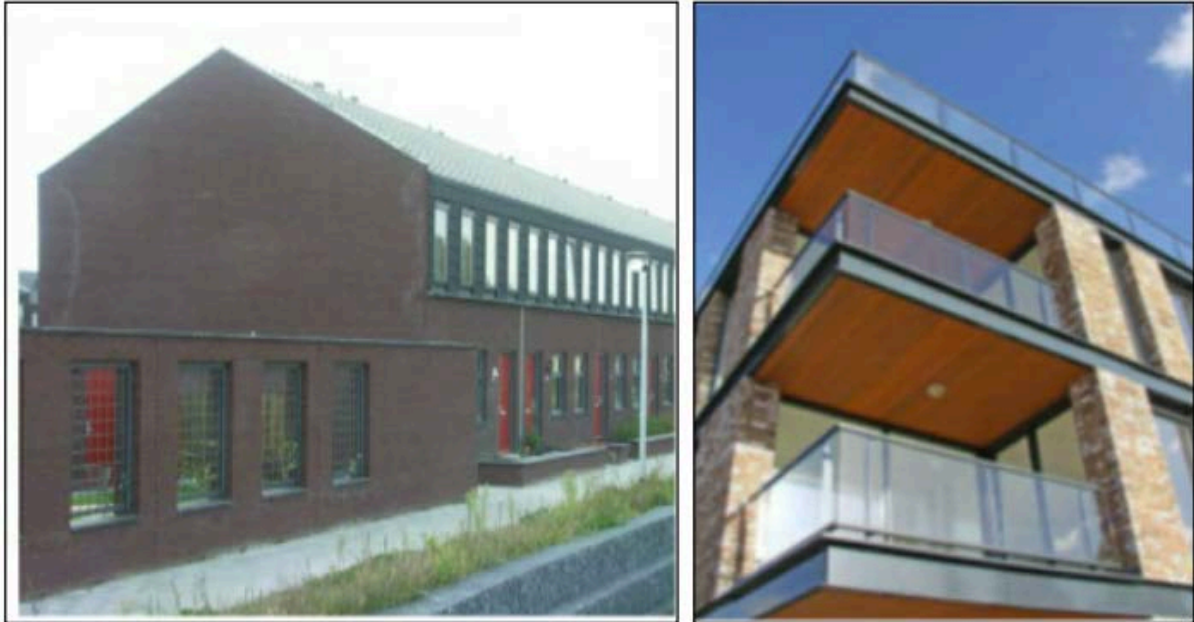
Afbeelding 3.1 Voorbeelden van een mee ontworpen erfafscheiding en een detaillering die een consequente afgeleide is van de vormgeving
