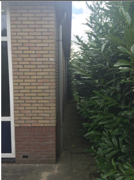
Westelijke zijgevel aanbouw
