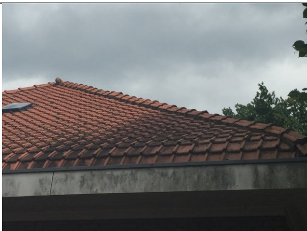
Aanzicht kap hoofdgebouw
