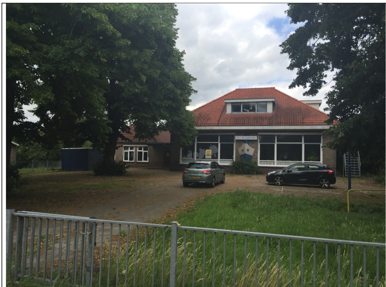
Aanzicht bestaande bebouwing voorzijde
