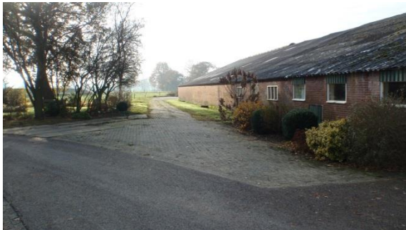
Figuur 8: Overzichtsfoto bebouwing
