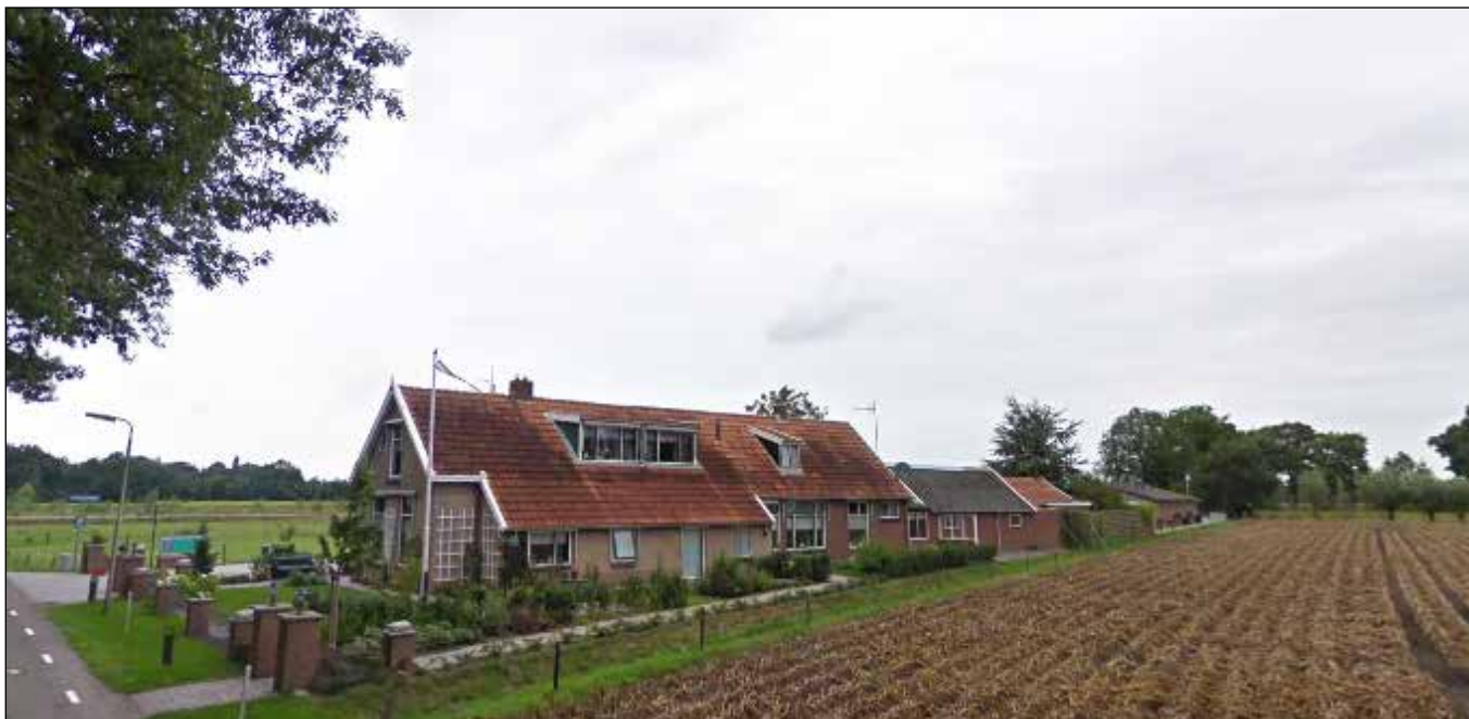
bestaande woning met bijgebouwen
