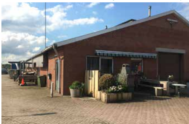
het front van de pluimveestal
