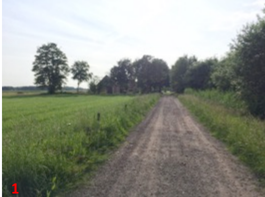
1 - de toegangsweg van puingranulaat
