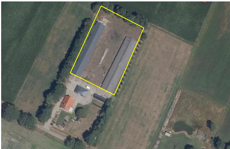
Begrenzing van deelgebied Kuilenweg; deze wordt met de gele lijn aangeduid (bron luchtfoto: ruimtelijkeplannen.nl).
