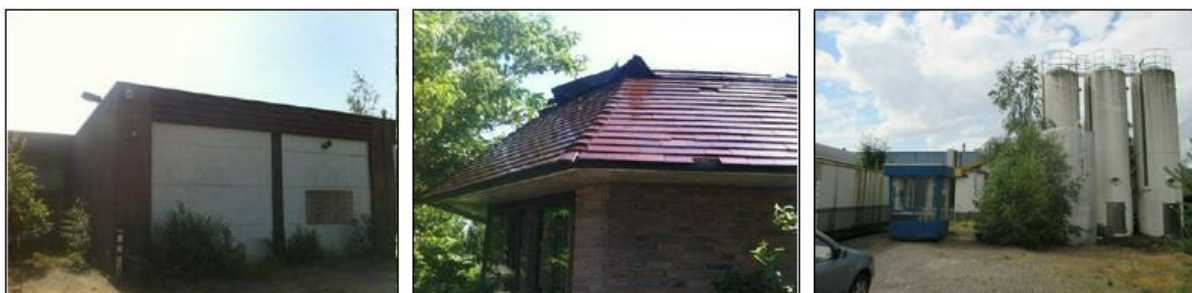
Figuur 2.2 Foto's en aanzicht van het plangebied (Bron: Google Streetview/ Natuurbank Overijssel/ Hamaland)
