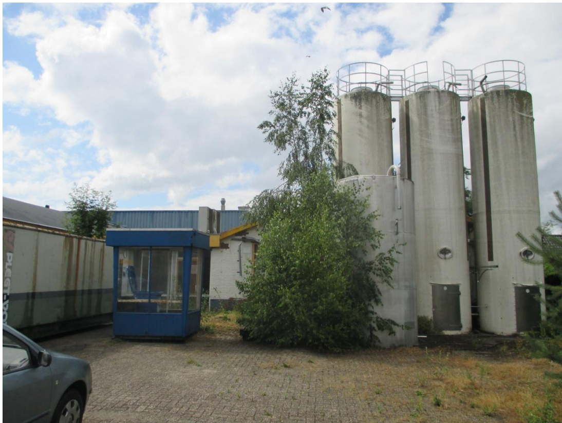
Afbeelding 19: Impressie van de onderzoekslocatie. De foto is genomen op het achterterrein in de richting van de Kanaalweg-Oost (noordwestelijke richting). Op de voorgrond zijn de graansilo's zichtbaar van de voormalige broodfabriek.
