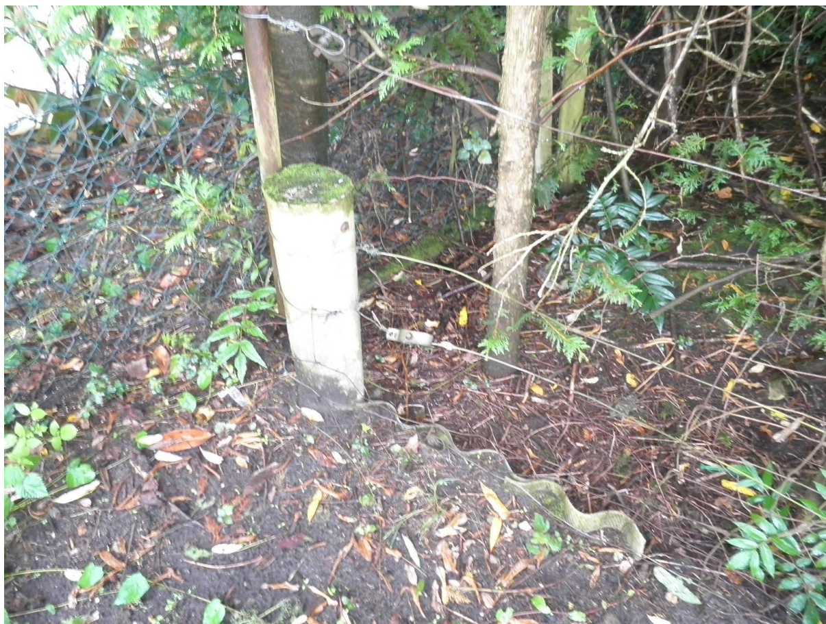
Foto 2: ingegraven mogelijk asbesthoudende beplating
