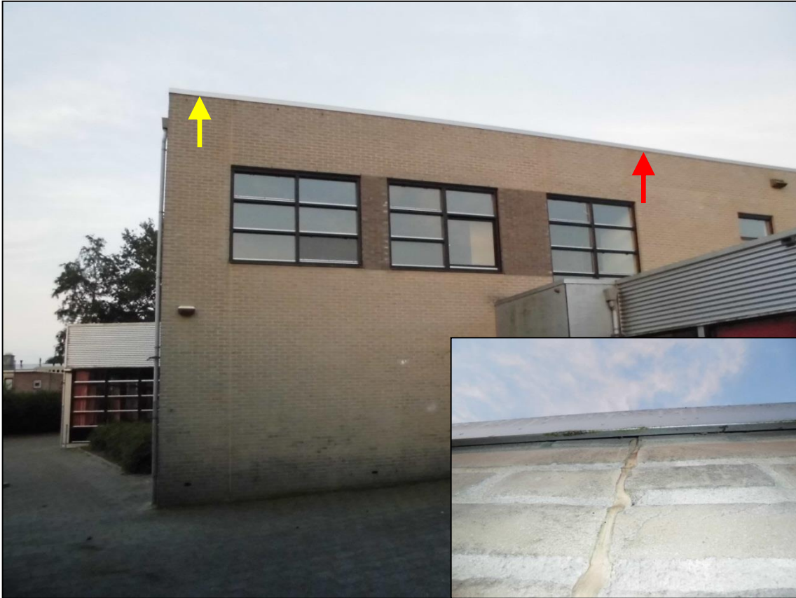
Figuur 2. Invliegopeningen gewone dwergvleermuizen onder metalen afdekkap van de noordgevel van de hoogbouw
