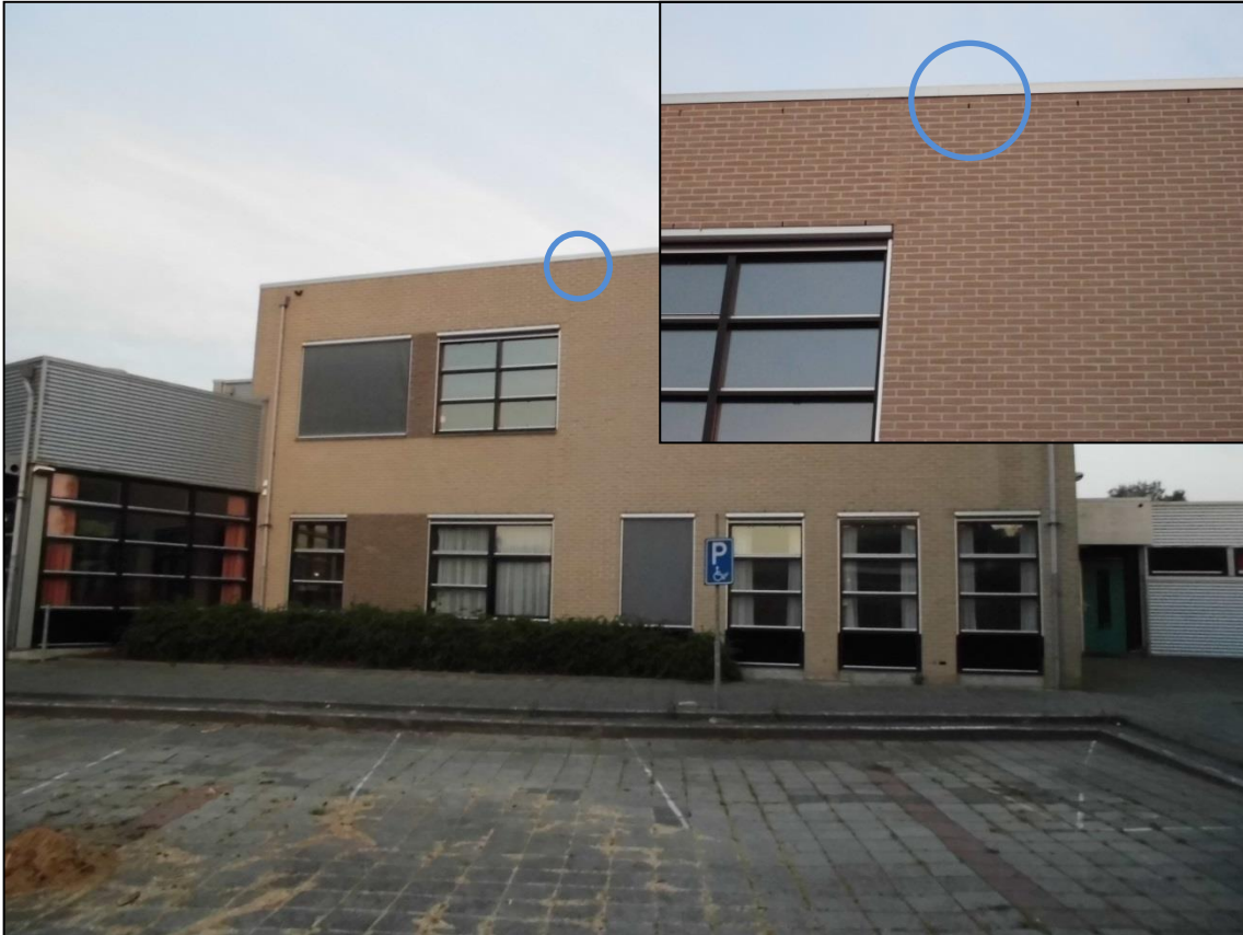
Figuur 1. Open stootvoeg boven in oostgevel van de hoogbouw, die functioneert als invliegopening voor gewone dwergvleermuis
