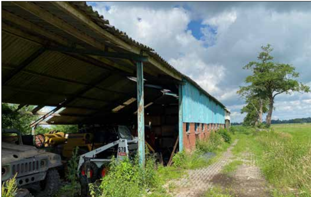
te slopen schuur
