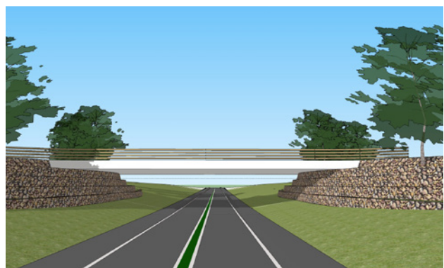
2. Bomen staan op de landhoofden van schanskorven, flauwe taluds zorgen voor optimaal doorzicht
