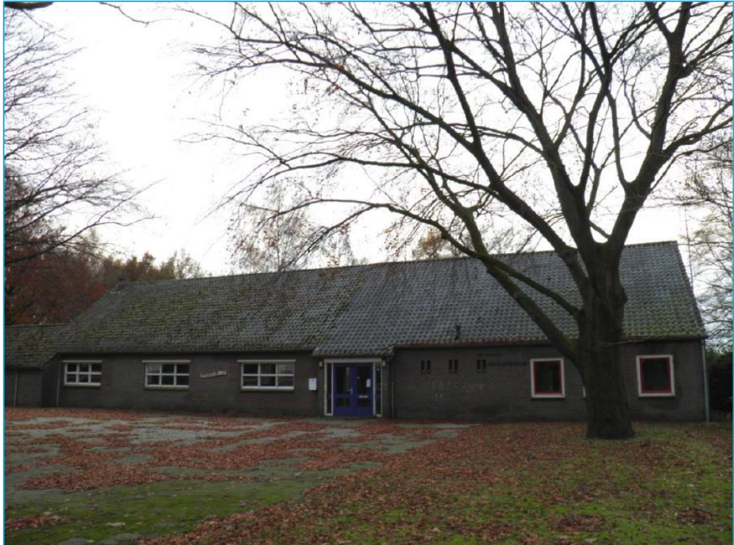
Te slopen voormalig schoolgebouw
