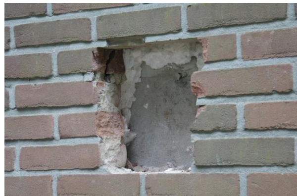
Figuur 2 & 3. De spouwmuur bleek geheel opgevuld te zijn en geen ruimte te bieden voor vleermuizen.
