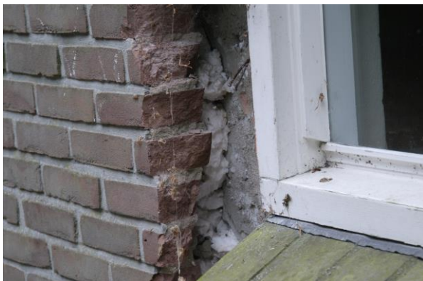
Figuur 2 & 3. De spouwmuur bleek geheel opgevuld te zijn en geen ruimte te bieden voor vleermuizen.
