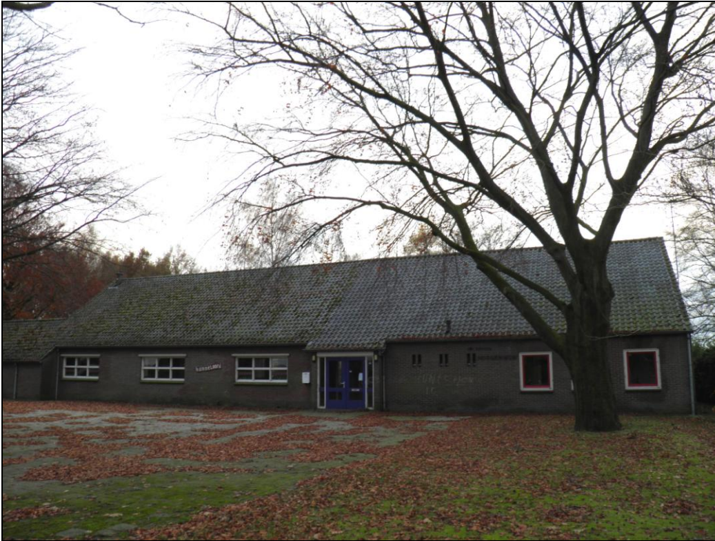
Figuur 2. Vooraanzicht van het voormalige schoolgebouw aan de Hoogenweg.
