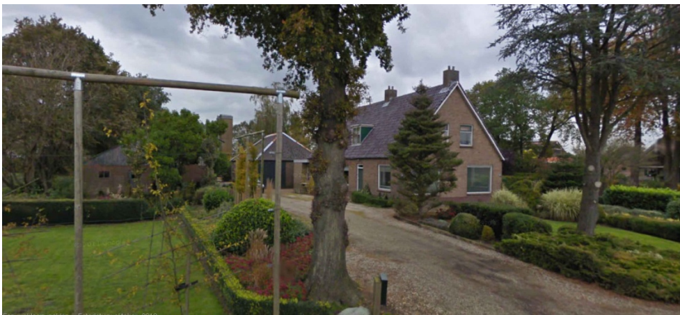
Figuur 2. Vooraanzicht van de woning en de aanbouw
