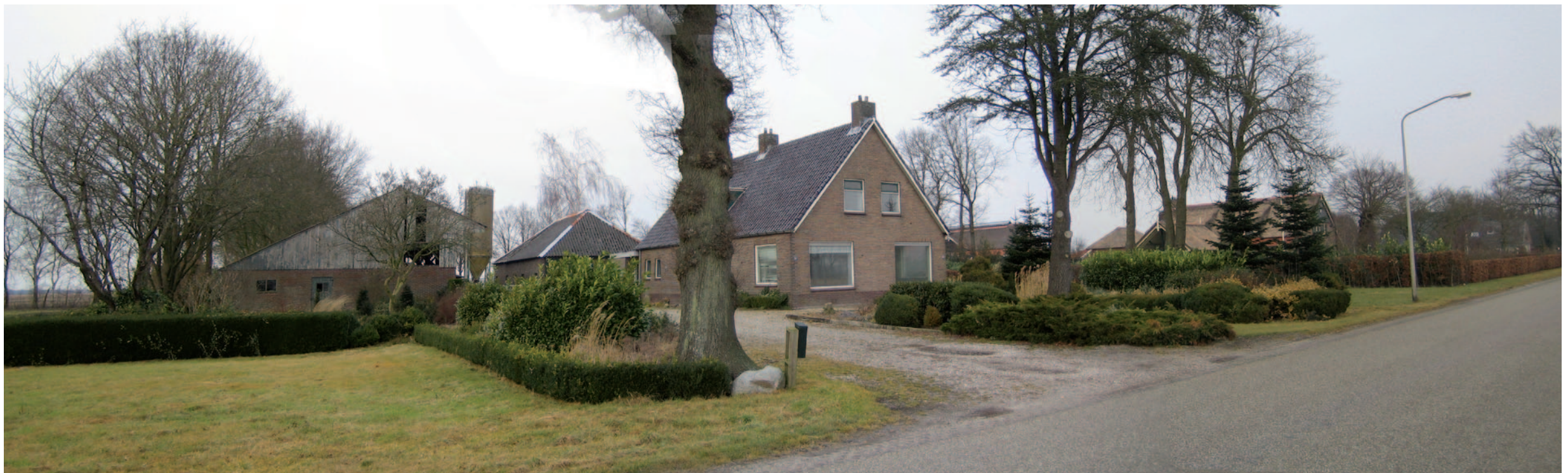
Anerveenseweg nummer 54 en 56 (plangebied). Achter de woning zijn de kapschuur en de knikschuur te zien. Op de achtergrond (rechts) staat de rietgedekte woning van de initiatiefnemer.
