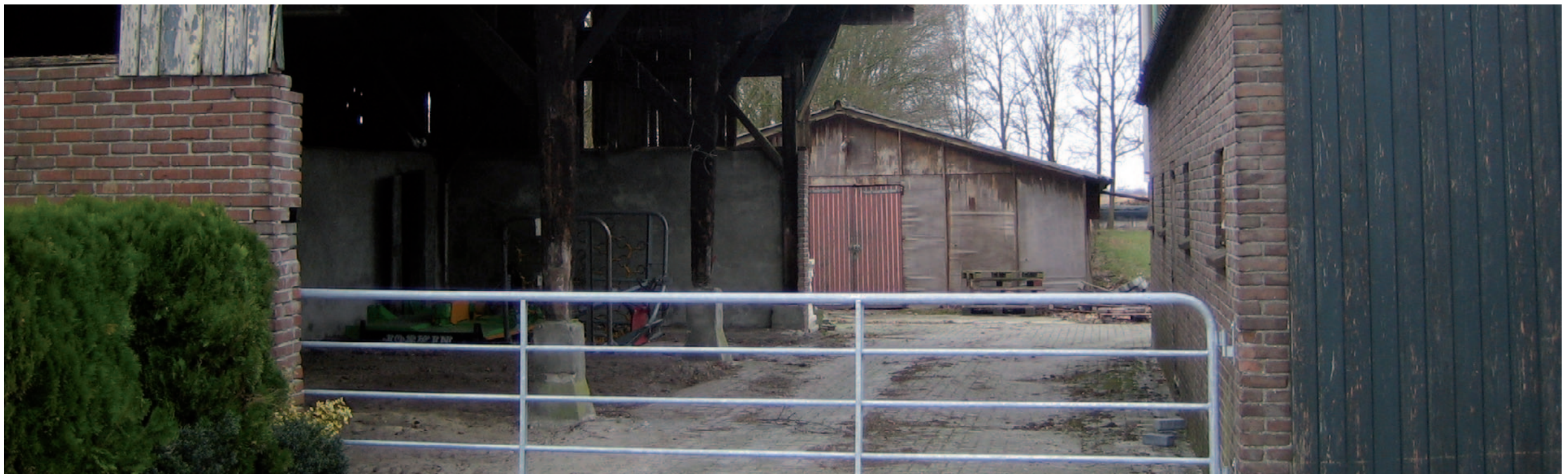
Zicht op landschapsontsierende schuur tussen kapschuur en knikschuur door.
