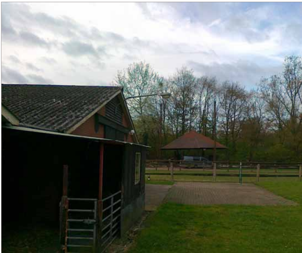
Afbeelding 4. Te slopen schuur
