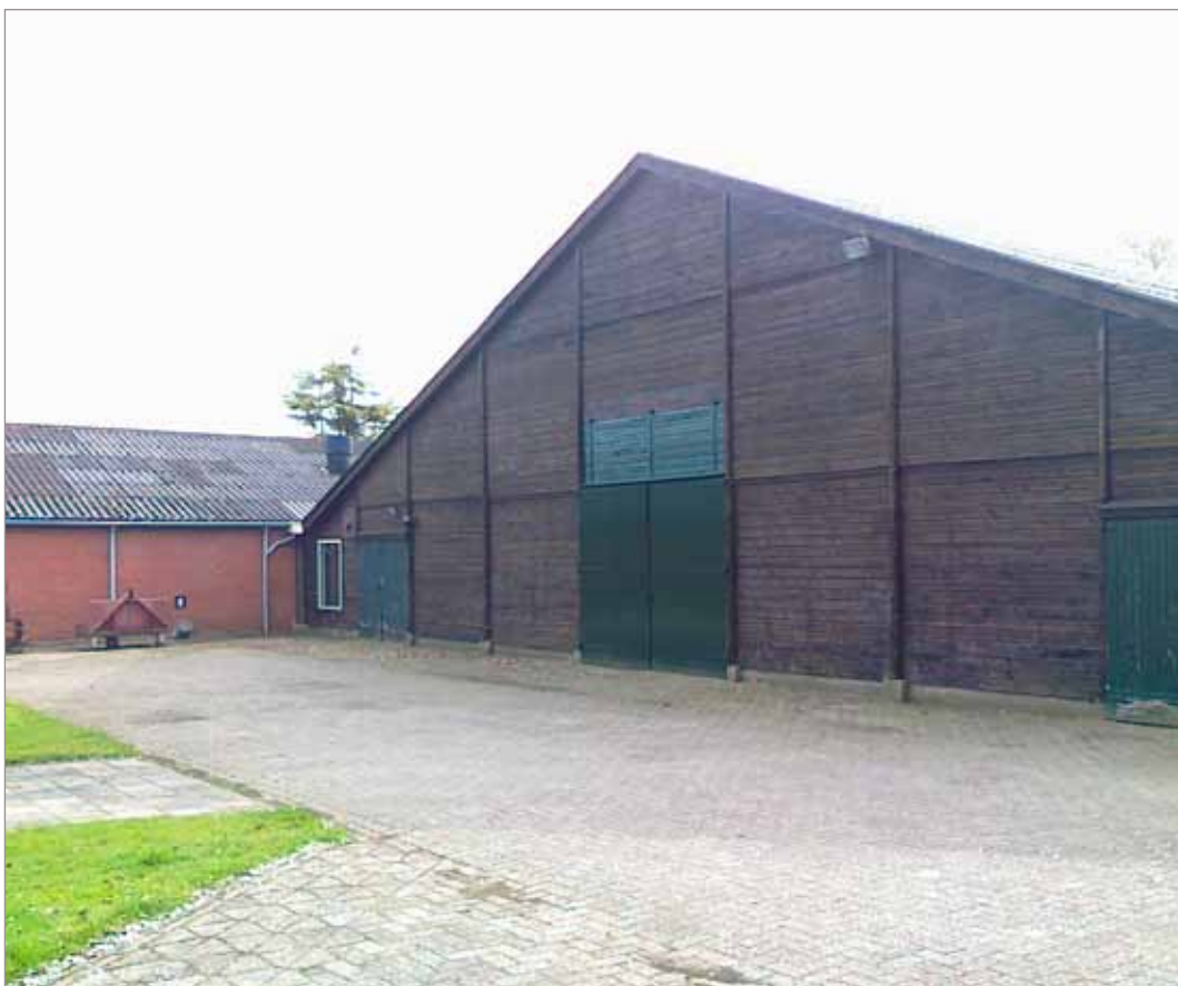
Afbeelding 6. Te slopen schuur
