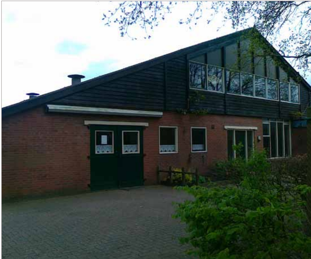
Afbeelding 5. Te slopen schuur
