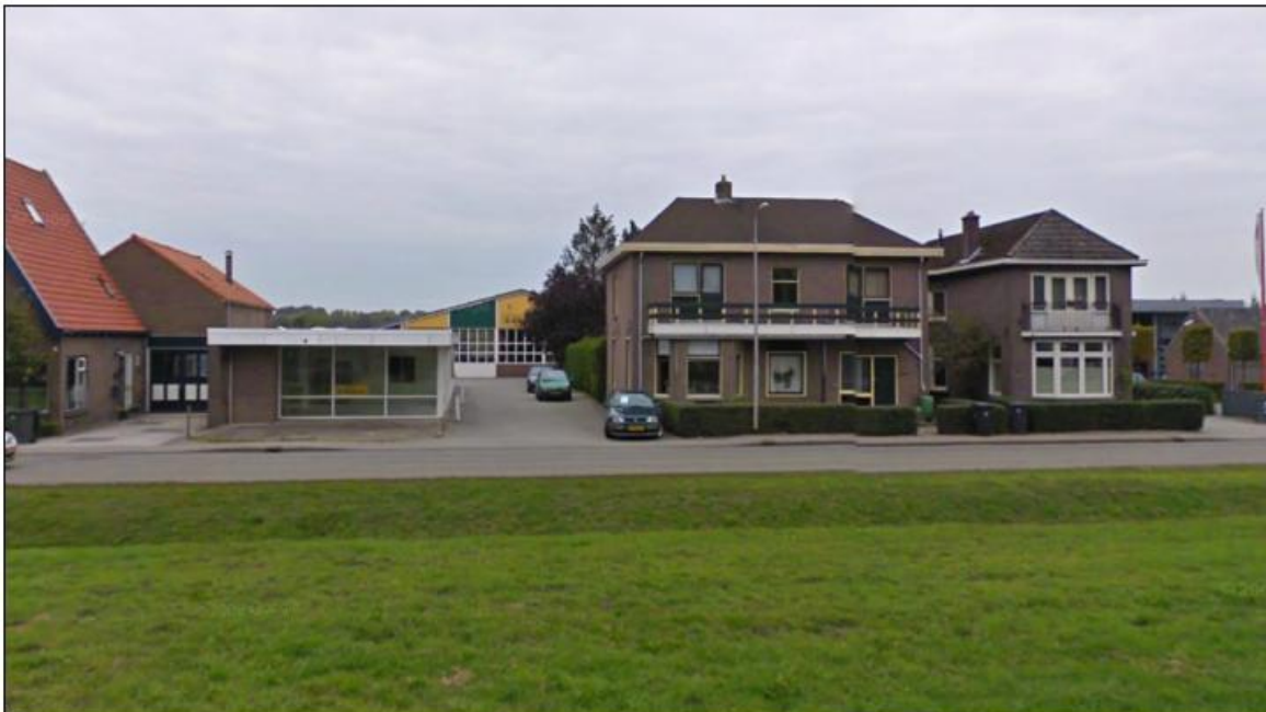
Figuur 2.3 Huidige situatie van het plangebieden de directe omgeving gezien vanaf de Hoofdvaart (Bron: Google Streetview)
