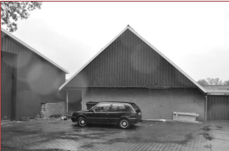
Figuur 2 Links de te behouden loods
