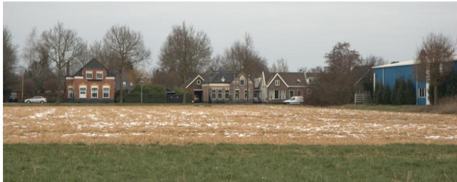
Plangebied gezien vanuit het zuiden. De bebouwing staat aan de overzijde van de Dedemsvaart.
