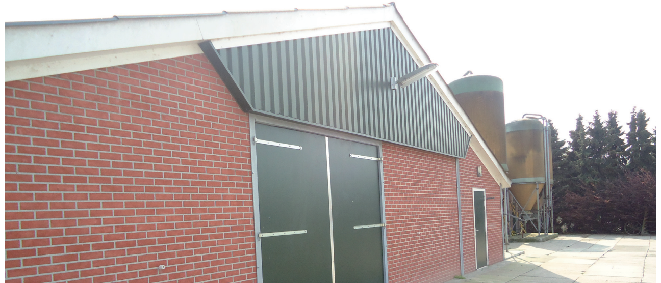
Groen damwand op gevels van de schuren
