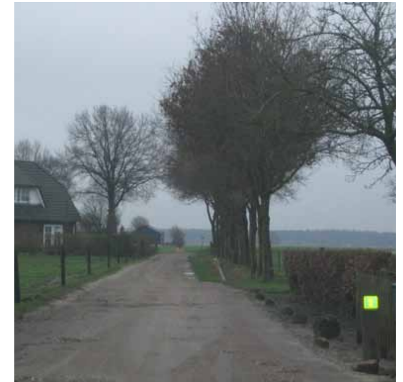
Schutsweg halfverhard. Zicht op Rheezeveenseweg en rechts op de foto het plangebied.
