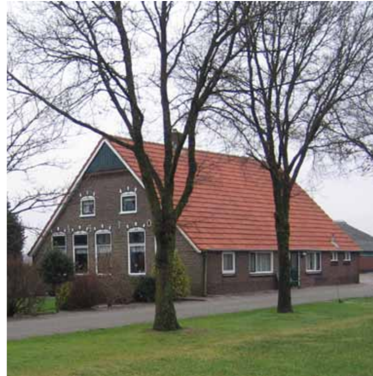
Bestaande woning aan de Rheezeveenseweg met een eenduidige basisvorm, kleurstelling gedekt.
