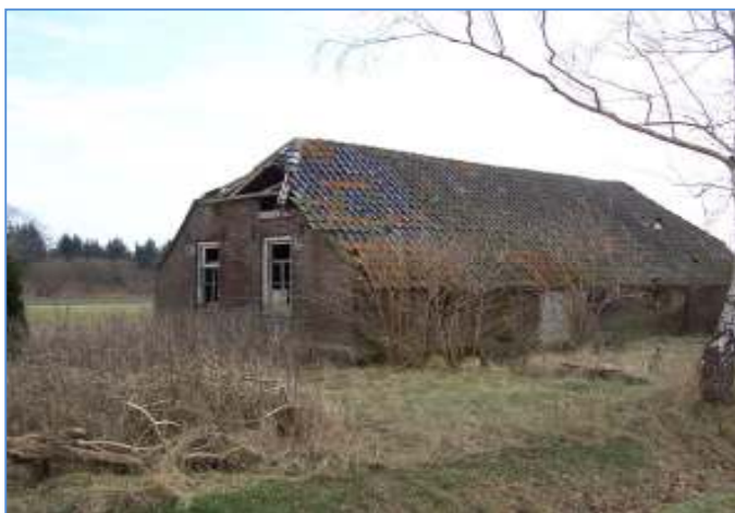
Foto 1 : vervallen woning aan de Spekopswijk 2.
