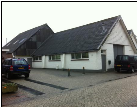
2. Gevel werkplaats Marsman
