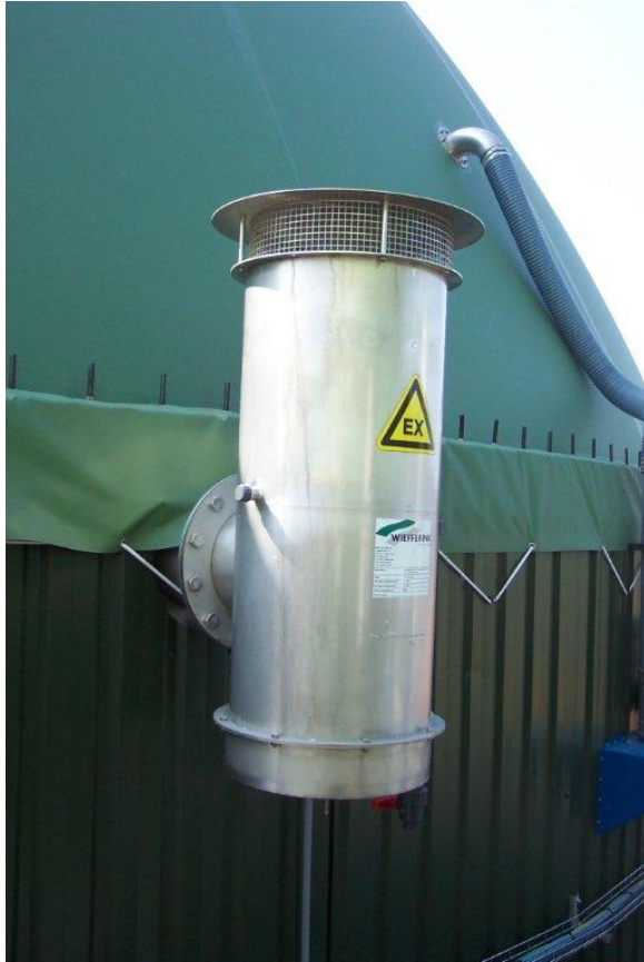
Foto 2: de mechanische overdruk- en onderdrukbeveiliging
