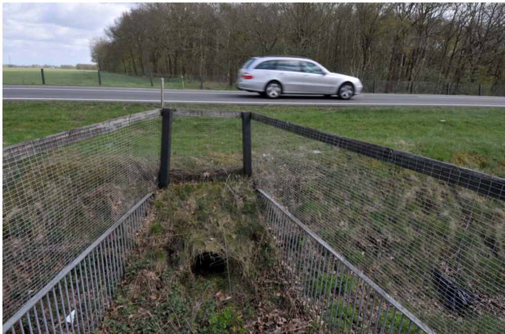
Figuur 6. Dassentunnel bij locatie 1 Oosterveld. Deze tunnel wordt niet gebruikt door dassen. (Foto: Monique Achterberg).
