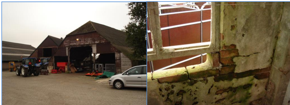
Afbeelding 5.1: te slopen hooischuur en met enkelsteense muur
