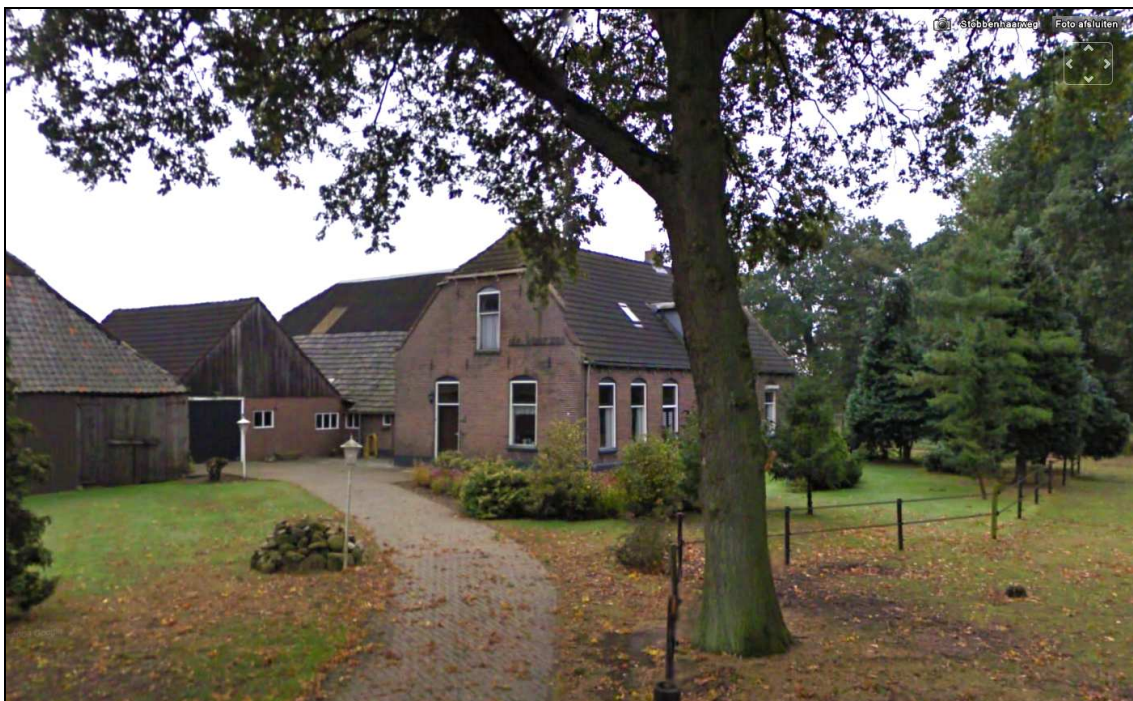
De huidige situatie; de schuur in het verlengde van de oprit zal worden gesloopt (foto: Google Streetview)
