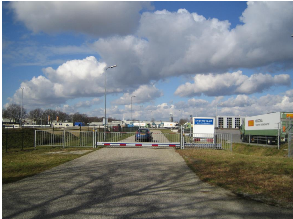
Figuur 16. Foto slagboom Archimedesstraat (bron: SAB)
