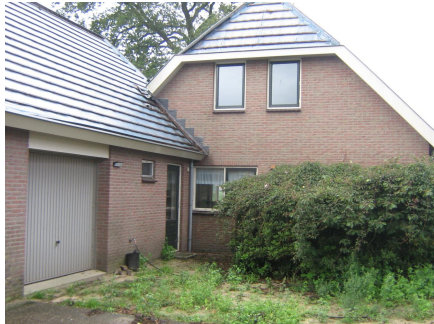
Foto 2: Het woonhuis de pannen zijn al verwijderd.
